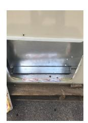
STEP 8: ATTACH SIDE ANGLE TO THE SIDE OF THE ECONOMIZER USING HOLES AND SCREWS PROVIDED.
